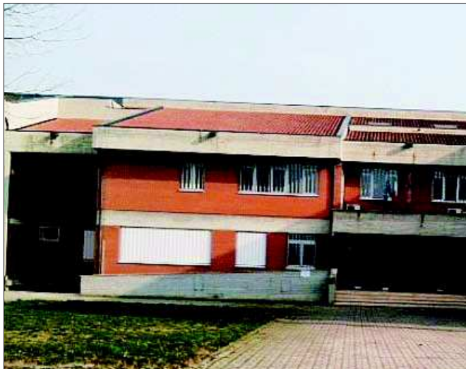
La scuola di Taglio di Po. Presto il via ai lavori
